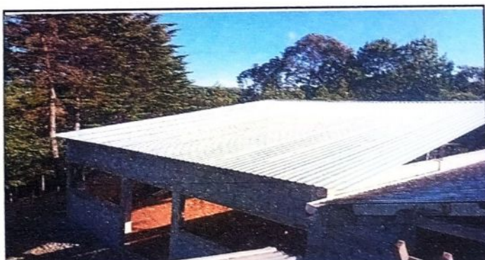
Foto 5 vista panoramica de la escuela despues de finalizar del trabajo de remozamiento se instalaron las laminas troqueladas.
