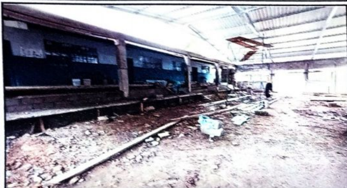
Foto 1 Vista panorámica de la rehabilitación, se instala las laminas troqueladas. Se instalara una division movable o corrediza , la terminacion la rehabilitacion de aula ,se finaliza el trabajo de
