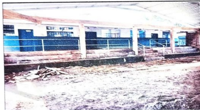
Foto 4: Observandose los diferentes procesos realizados en la rehabilitacion de aulas. sustitucion de reglas por columnas.
