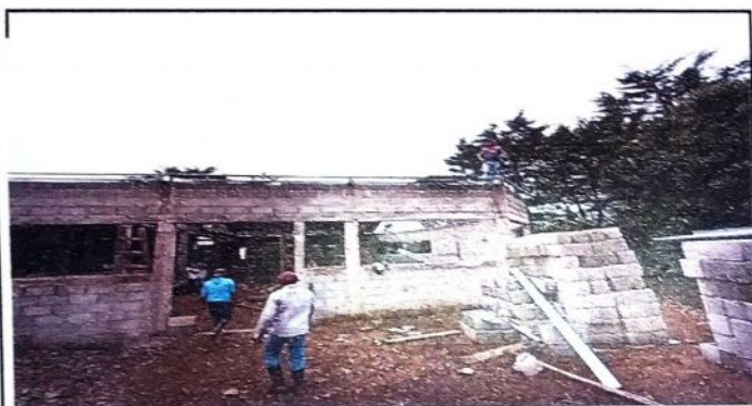
Foto 3: como se muestra en la fotografia instalacion de Costaneras y laminas troqueladas de la rehabilitacion de aula. El 100%
